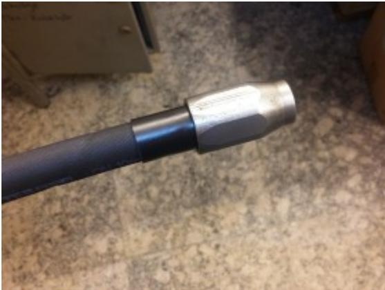
Anschliessend Fitting und Schlauchinnenseite in der Armatur ebenfalls mit Kälteöl (PAG, zb ISO46) einstreichen und eindrehen (normales Rechtsgewinde):
